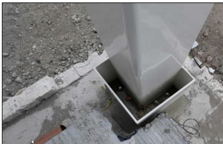
Fig. 4.9 Exemplu de îmbinare la bază accesibilă [30]
