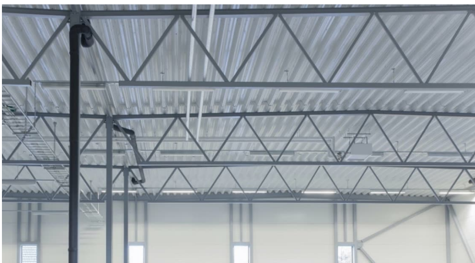
Fig. 4.23 Exemple de système de toiture avec tôle nervurée de hauteur importante [31]
