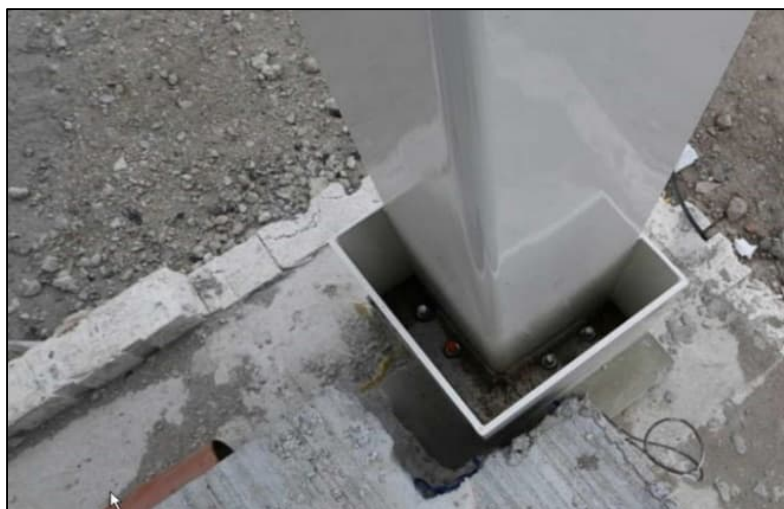
Fig. 4.9 Exemple d'assemblage de pieds de poteau accessible [30]
