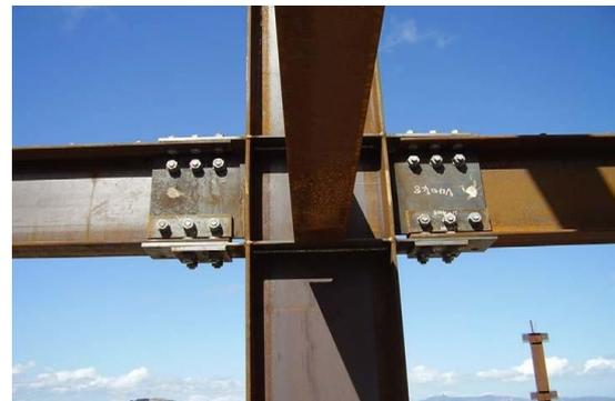
Figure 2.7 : Charnière coulissante avec amortisseurs à friction asymétriques du primé de Te Puni Village à Wellington -[13]
