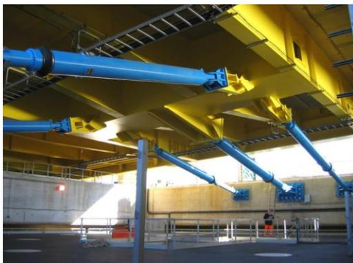
Figure 2.1 : Amortisseurs visqueux placés sur le pont de Rion-Antirion (Grèce) - (Courtesy : FIPMEC srl)
