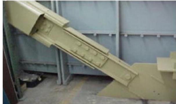
Figure 2.4 : Dispositifs Pall installés sur un contreventement à diagonale unique à l'usine d'avions commerciaux Boeing d'Everett, États-Unis - (Avec l'aimable autorisation du Dr Pall)
