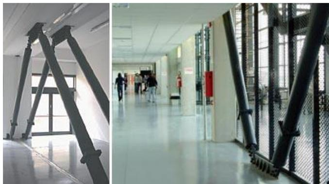
Figure 2.2 : Contreventements anti-flambement installés dans une structure préfabriquée en béton armé à Ancône (Italie) - (Courtoisie : FIPMEC srl)
