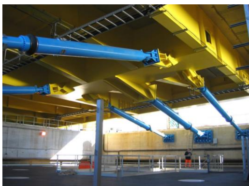
Фигура 2.1 – Вискозни демпфери на моста Рион – Антирион, Гърция (с позволението на FIRMEC srl)
