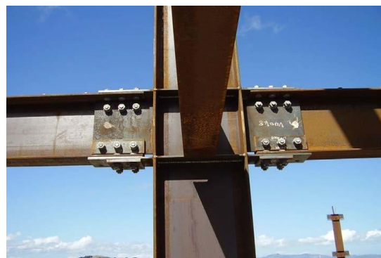
Фигура 2.7 – Възел с плъзгаща се става с асиметрични фриktionни демпфери - Te Puni Village, Уелингтън, Нова Зеландия [13]
