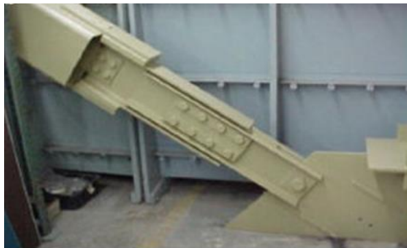
Фигура 2.4 – Pall – фрикционно устройство, инсталирано върху диагонал от вертикална връзка на Boeing Commercial Airplane Factory Everett, USA (с позволение на Dr Pall)
