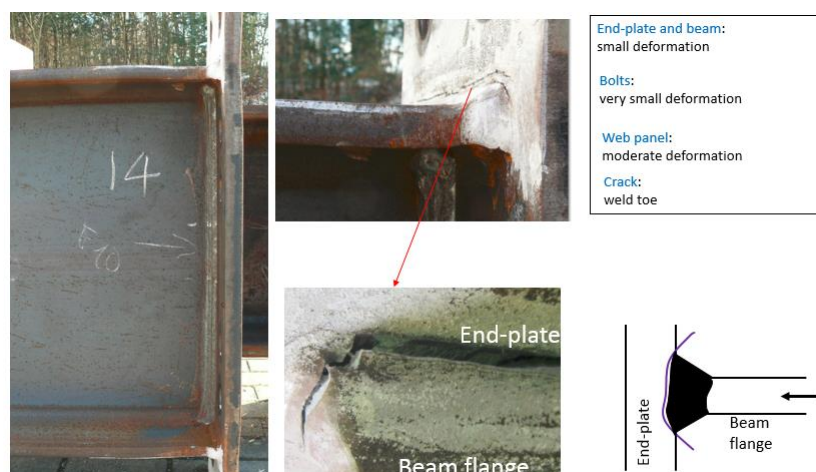
Figura 6.33: Juntas E3-TB-E: modo de rotura
