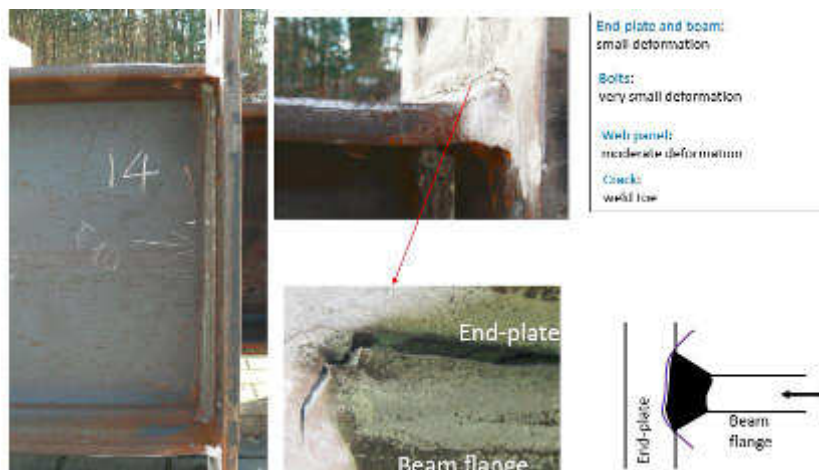
Figure 6.33 : Mode de ruine de l'assemblage E3-TB-E
