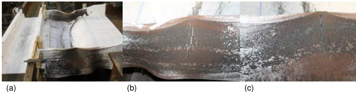
Figure 6.42: Réponse expérimentale de l'échantillon SP2: (a) Déformation globale de la connexion; (b) et (c) Fissures au niveau des semelles de la poutre
